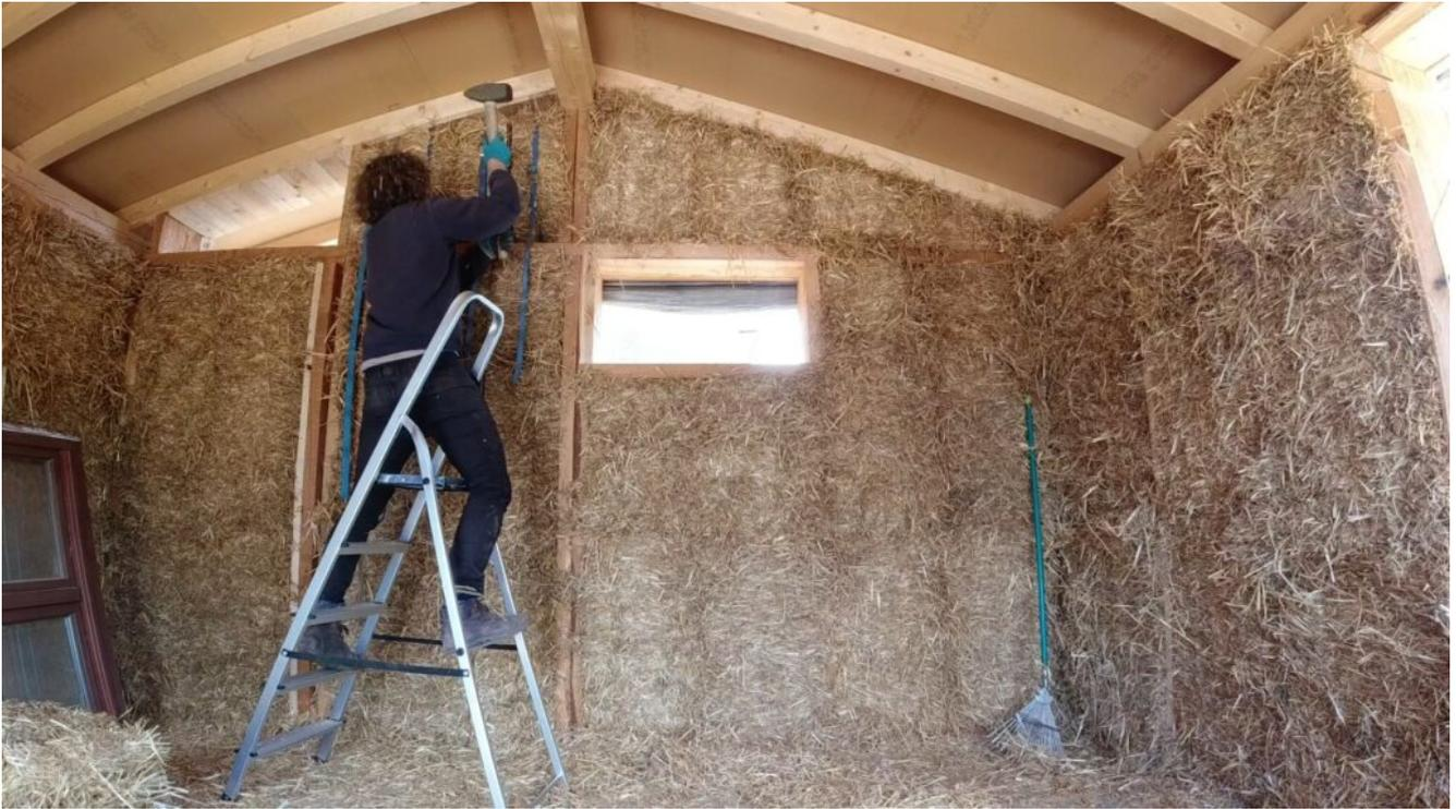
*Die Strohballen mussten nach dem Einsetzen in das Ständerwerk noch komprimiert werden.*
